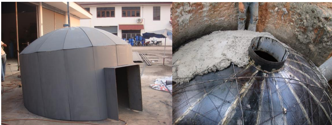
ภาพการก่อสร้างบ่อแก๊สชีวภาพโดยใช้แบบถาวร
