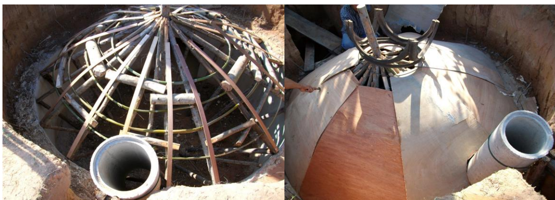
ภาพการก่อสร้างบ่อแก๊สชีวภาพโดยใช้แบบชั่วคราว
